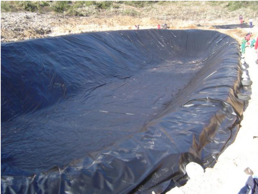
Umjetno jezero SMS-a pri završetku ugradnje
